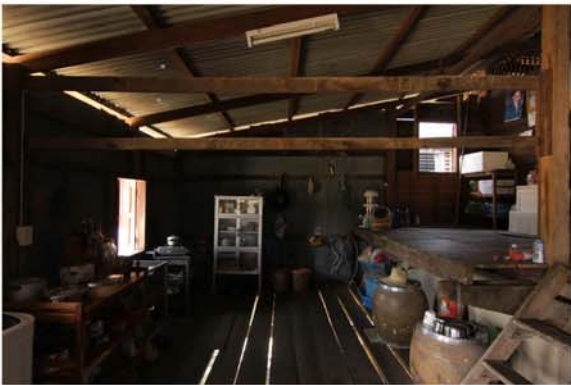
หลังคาพาไลเดิมใช้สังกะสี ปัจจุบันเปลี่ยนเป็นกระเบื้องลอน
