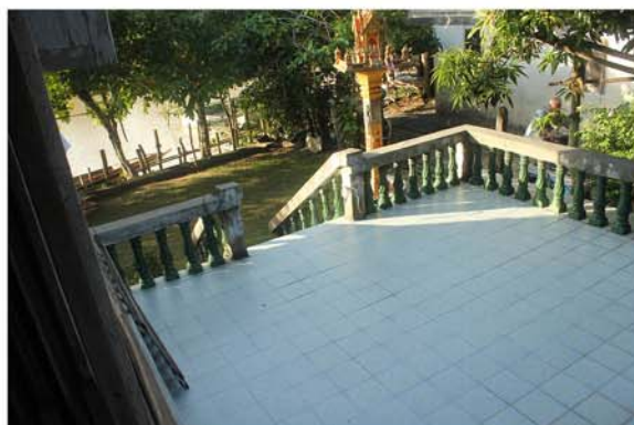
ชานแดด ที่มีลักษณะเป็นโครงสร้างคอนกรีต
