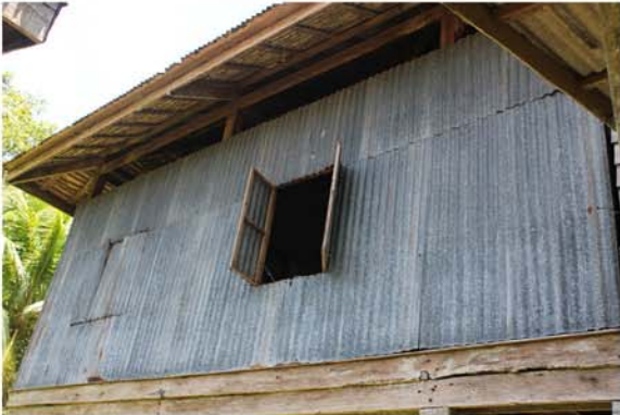
การใช้ผนังสังกะสีตั้งแต่แรกสร้าง และการเปิดช่องระบาย อากาศเหนือผนัง
