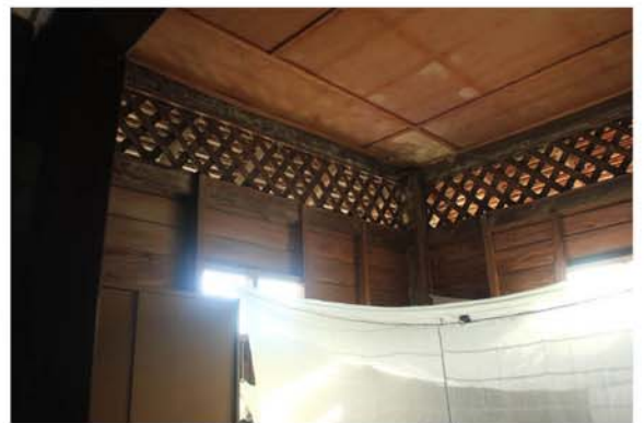
บริเวณเหนือผนัง มีลักษณะเป็นช่องลมเพื่อระบายอากาศ
