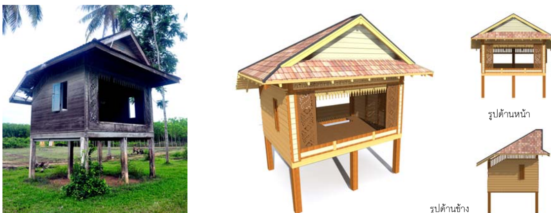
ภาพที่ 3-30: "โรงหนัง" หรือ "โรงหนังลุง" แบบถาวรของวัดเลียบ อ.คลองหอยโข่ง จ.สงขลา ซึ่งสร้างเป็นอาคารยกพื้นสูงจากพื้นประมาณ 2.50 เมตร เพื่อให้ผู้ชมนั่งดูได้ไม่บังกัน และภาพสามมิติแสดงโรงหนังวัดเลียบที่มีการตกแต่งด้วยแผ่นไม้ฉลุลายอย่างงดงาม โดยมีแนวคิดมาจากแสงเงาที่ลอดผ่านตัวหนังนั่นเอง ในภาพจะเห็นการเจาะช่องบนพื้นเพื่อเป็นช่องให้นายหนัง และคณะขึ้นมาบนอาคารได้
