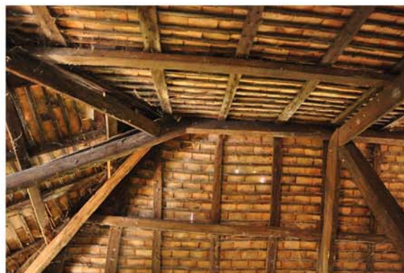
ลักษณะโครงสร้างหลังคา และวัสดุผนังกระเบื้องดินเผา
