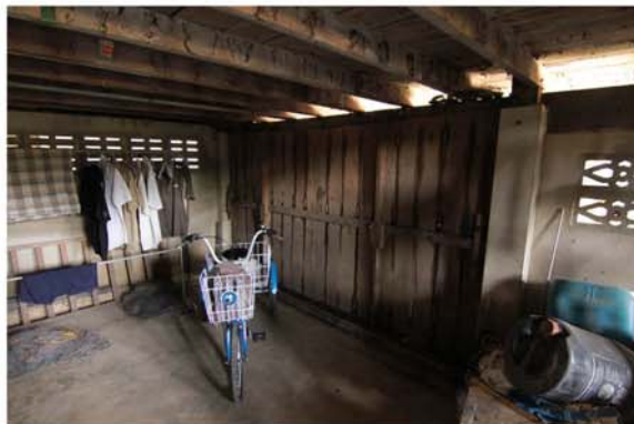
บริเวณใต้ถุน สร้างผนังปูนล้อมเมื่อ 15 ปีที่แล้ว เป็นที่เก็บของ และห้องน้ำ โดยมีประตูเปิดออกด้านที่ติดกับทางสาธารณะ
