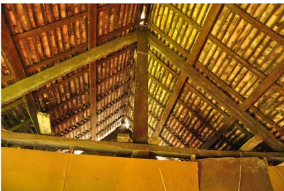
ลักษณะของหลังคาทรงจั่ว พบการใช้ซ็อนนอนและเสาดั้ง ซึ่งเป็นโครงสร้างหลังแบบดั้งเดิม
