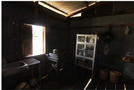
พื้นที่ครัว เปลี่ยนจากผนังไม้จริงมาเป็นผนังสังกะสี
