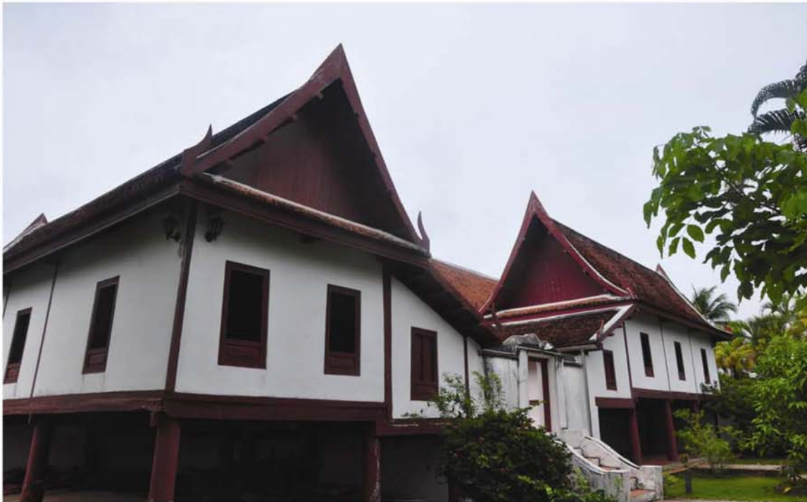
มีลักษณะการวางผังแบบเรือนหมู่ ประกอบด้วยเรือนประธาน 1 หลัง เรือนเล็ก 3 หลัง และเรือนครัว 1 หลัง ล้อมรอบลานบริเวณตรงกลาง มีซุ้มประตู 3 ด้าน รูปทรงหลังคามีลักษณะเป็นหลังคาทรงจั่วเตี้ย
