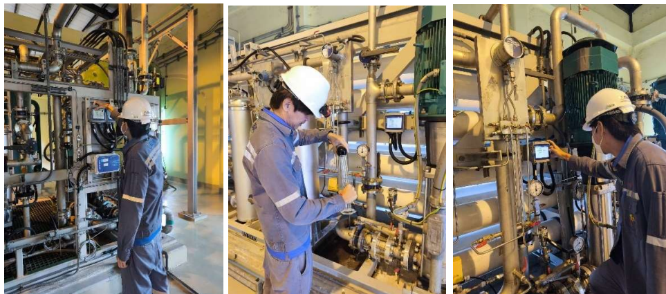
ภาพที่ 27 ตัวอย่างระหว่างทำการ Check Calibration of I&C Equipment
