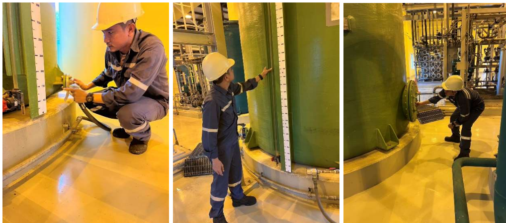
ภาพที่ 26 ตัวอย่างระหว่างทำการ Visual Check of RO Permeate Tank & Level
