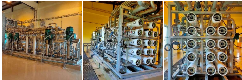
ภาพที่ 4 ภาพถ่าย Overview ของระบบจริง ระบบรีเวิร์สออสโมซิส กรณีศึกษา
