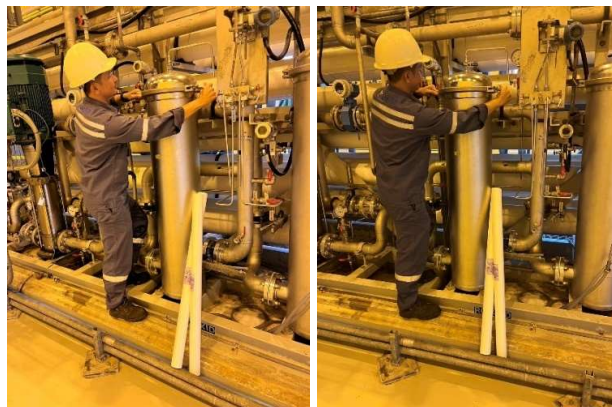
ภาพที่ 24 ตัวอย่างระหว่างทำการ Inspection & Clean of Cartridge Filter for RO
