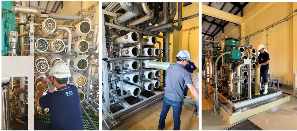
ภาพที่ 25 ตัวอย่างระหว่างทำการ Chemical clean of RO membranes
