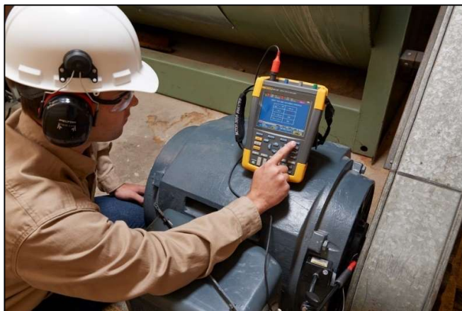
ภาพที่ 9 ตัวอย่างกิจกรรมการบำรุงรักษาเชิงป้องกันของมอเตอร์กระแสสลับ ที่มา: Fluke Corporation. (2024). Vibration Testing Equipment. Retrieved March 9, 2025, from https://www.fluke.com/
