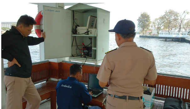
ปรับปรุงซ่อมแซมสถานีวัดระดับน้ำ
