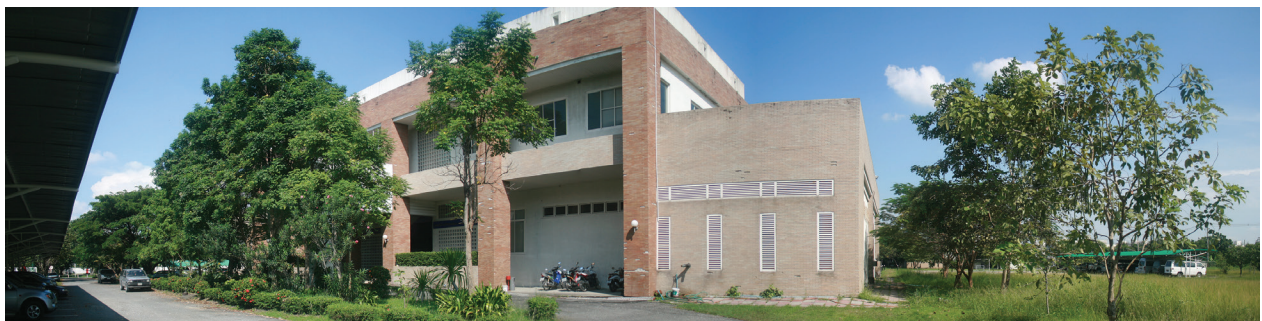
อาคารที่ทำการศูนย์สนับสนุนการเดินทางเรือ
