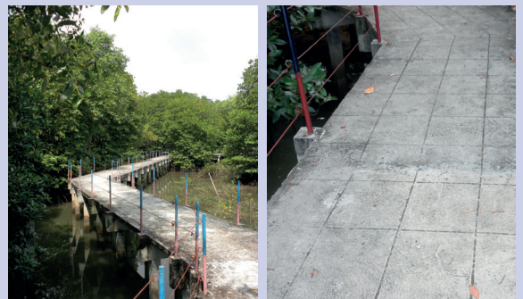
ทางเดินเท้าคอนกรีต มีร่องกันลื่นและลวดซึ่งเป็นราวจับตลอดเส้นทาง
