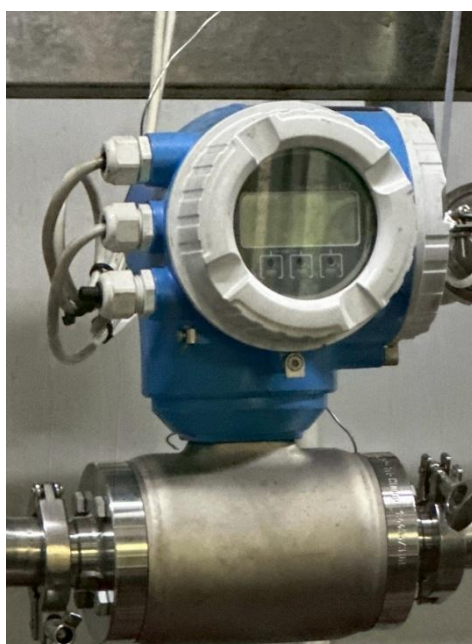
ภาพที่ 20 ถังปรุงผสมก่อนติดตั้ง Flow meter และภายหลังการติดตั้ง Flow meter
