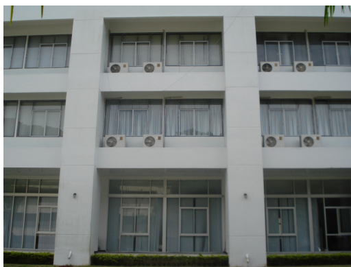
ภาพประกอบที่ ซ.4 แสดงการติดตั้งระบบเครื่องปรับอากาศด้านนอกอาคาร
