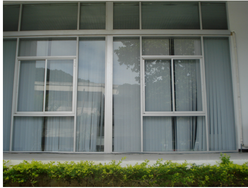
ภาพประกอบที่ ซ.7 แสดงการปิดม่านกันความร้อนจากภายนอก
