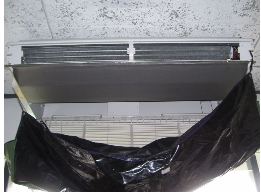
ภาพประกอบที่ ซ.13 แสดงการทำความสะอาดระบบเครื่องปรับอากาศ
