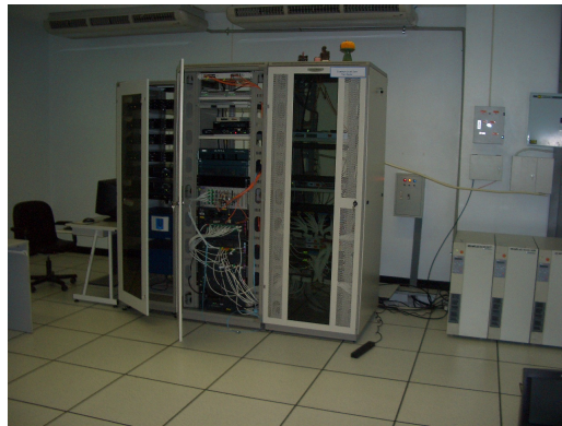
ภาพประกอบที่ ซ.14 แสดงการติดตั้งสวิตช์เบรกเกอร์ห้องปฏิบัติการคอมพิวเตอร์
