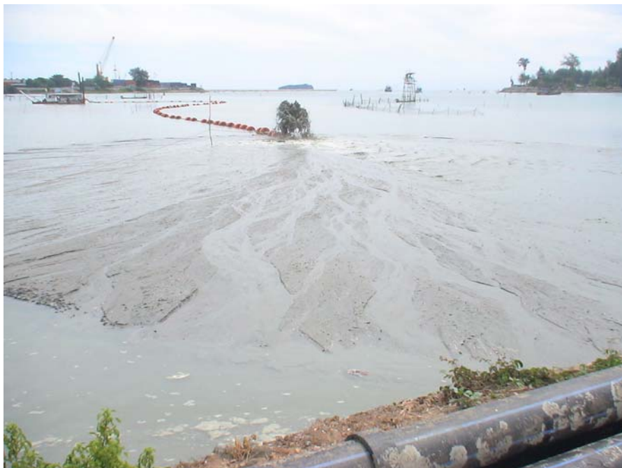
รูปที่ 5 ปฏิบัติการดูตะกอนทรายที่ทับถมในท่าเทียบเรือมาทดลองในพื้นที่จริง
