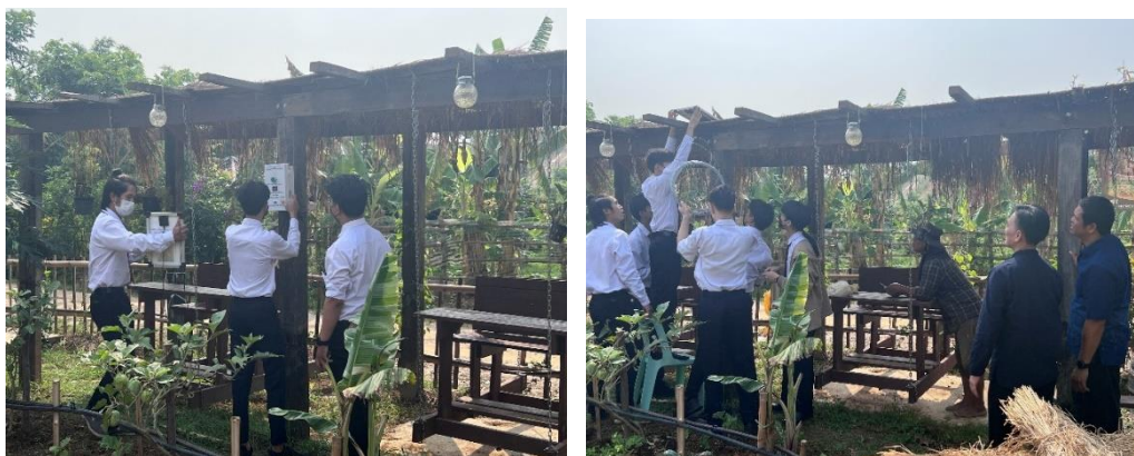
ภาพที่ 54 ติดตั้งระบบ
