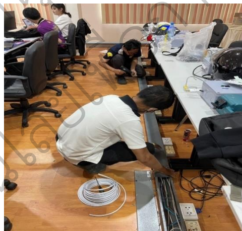
ผนวกภาพที่ 137 ติดตั้งปรับรางไฟฟ้า
