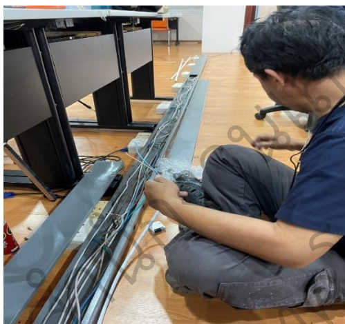
ผนวกภาพที่ 137 ติดตั้งปรับรางไฟฟ้า
