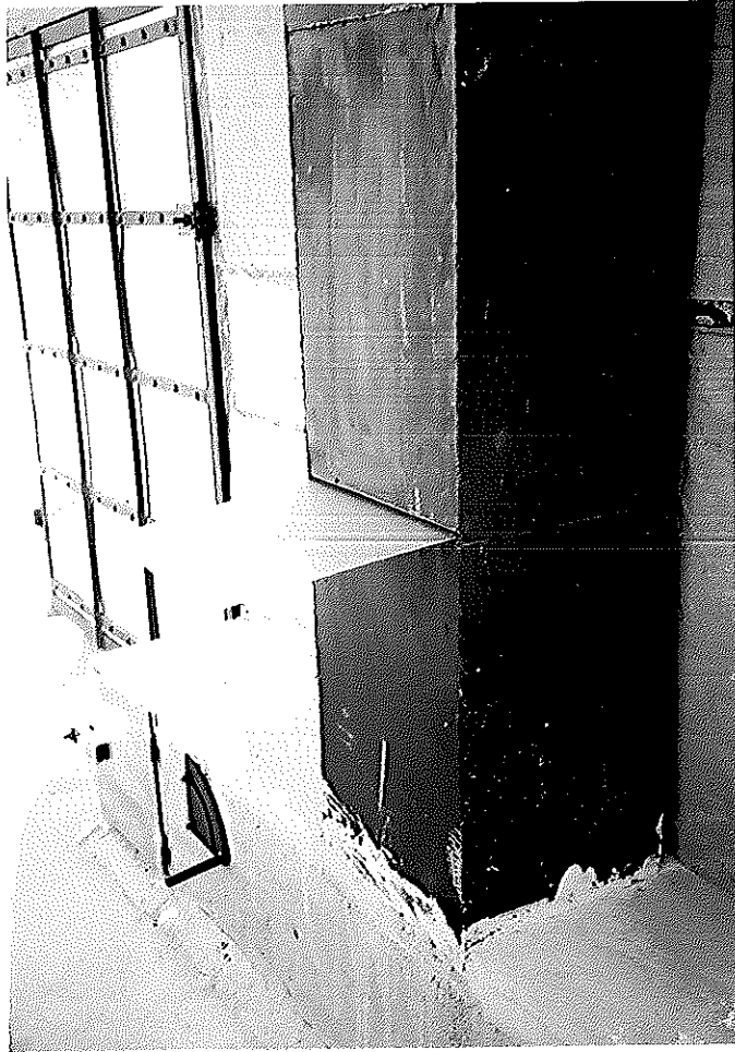
รูปที่ ผ.4.20 แดมเปอร์แบบเสียบที่ท่อทางเดินอากาศแนวตั้ง
