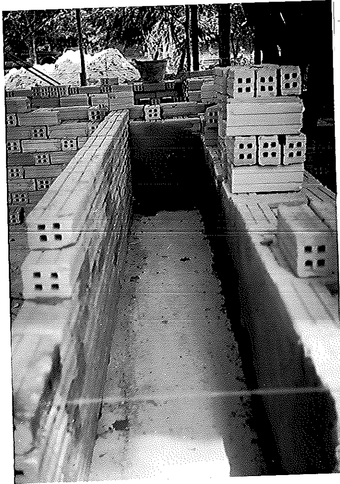
รูปที่ ผ.4.5 แนวก่ออิฐของซีเมนต์
