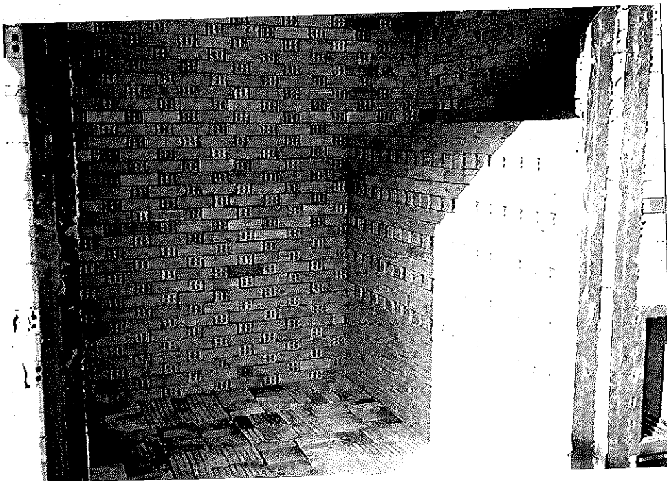
รูปที่ ผ.4.9 พื้นเตา ฉนวนเตา ฉนวนกันไฟที่ไม่ได้ฉาบปูนทนไฟ
