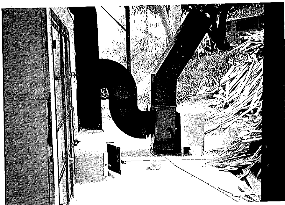
รูปที่ ๘.4.23 พัดลมดูดที่ติดตั้งกับท่อแนวตั้งพร้อมปล่องทางออก
