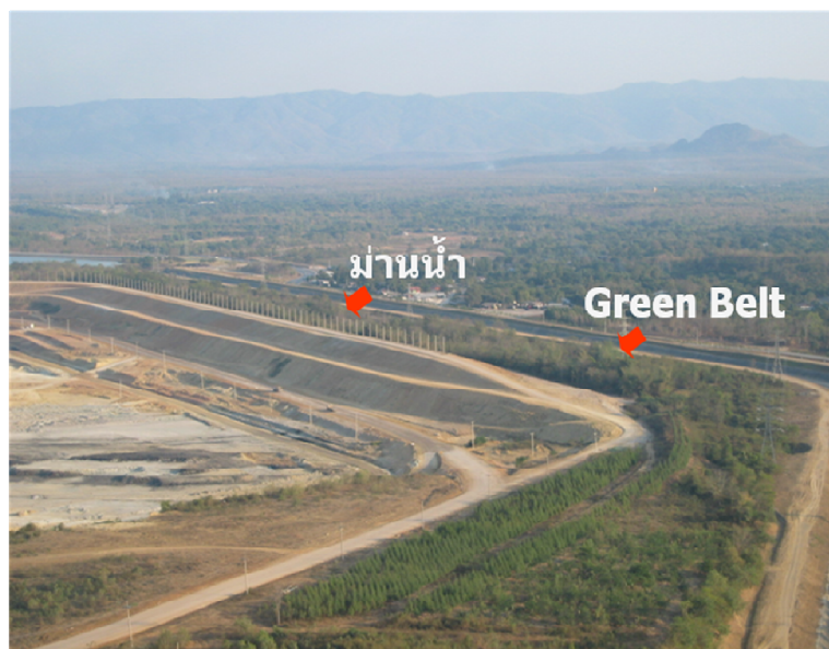
รูปที่ 4.9 การลดผลกระทบจากฝุ่นละอองด้วยภูมิทัศน์ โดยติดตั้งระบบสปาร์กน้ำ และแนวป้องกันธรรมชาติ (Green Belt)
