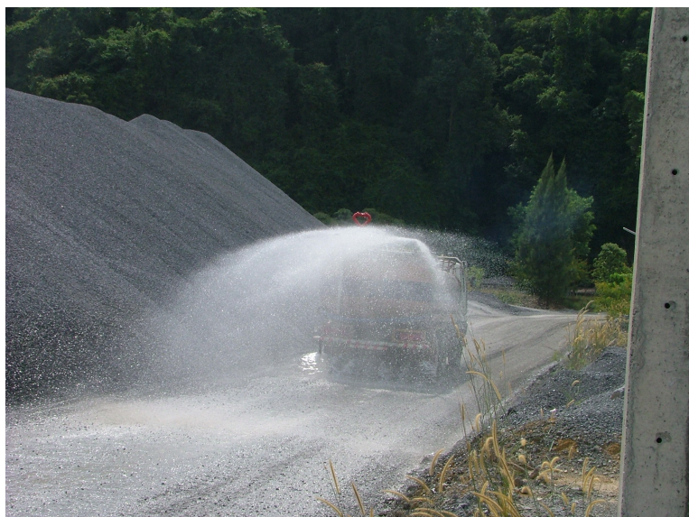
รูปที่ 5.10 ภาพถ่ายรถราคน้ำบนถนนเพื่อดับฝุ่นและป้องกันฝุ่น ถ่ายเมื่อวันที่ 7 กรกฎาคม 2553
