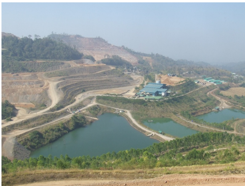
รูปที่ 4.19 ภาพบ่อคัดตะกอนและบำบัดน้ำของโรงลอยแร่ น้ำจากกระบวนการผลิตจะใช้หมุนเวียน ไม่ปล่อยสู่ภายนอก (ในภาพ มองเห็น โรงลอยแร่ และที่เก็บกองเปลือกดิน)
