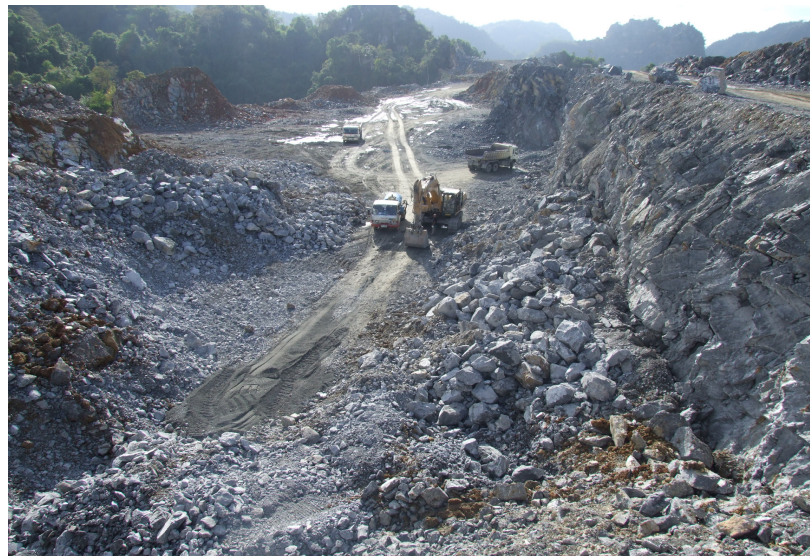
รูปที่ 5.6 ภาพถ่ายการลำเลียงหินจากหน้าเหมืองไปยังโรงโม่หิน ถ่ายเมื่อวันที่ 6 มกราคม 2553
