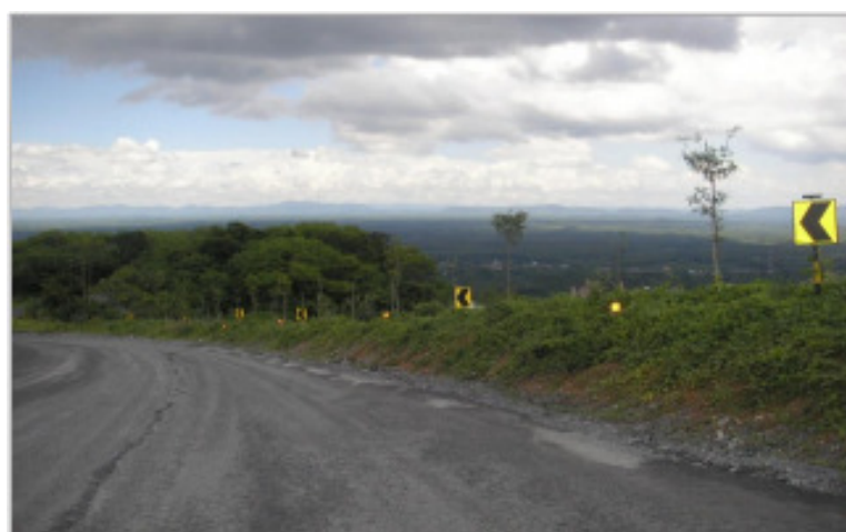
รูปที่ 4.48 พื้นที่ Buffer Zone ที่ใช้ติดป้ายสะท้อนแสงเพื่อให้เห็นได้เวลากลางคืน
