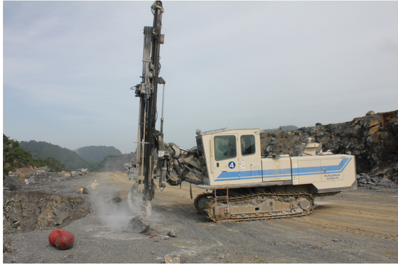
รูปที่ 5.5 ภาพถ่ายรถเจาะรูระเบิดขณะกำลังทำงาน ถ่ายเมื่อวันที่ 5 กรกฎาคม 2553
