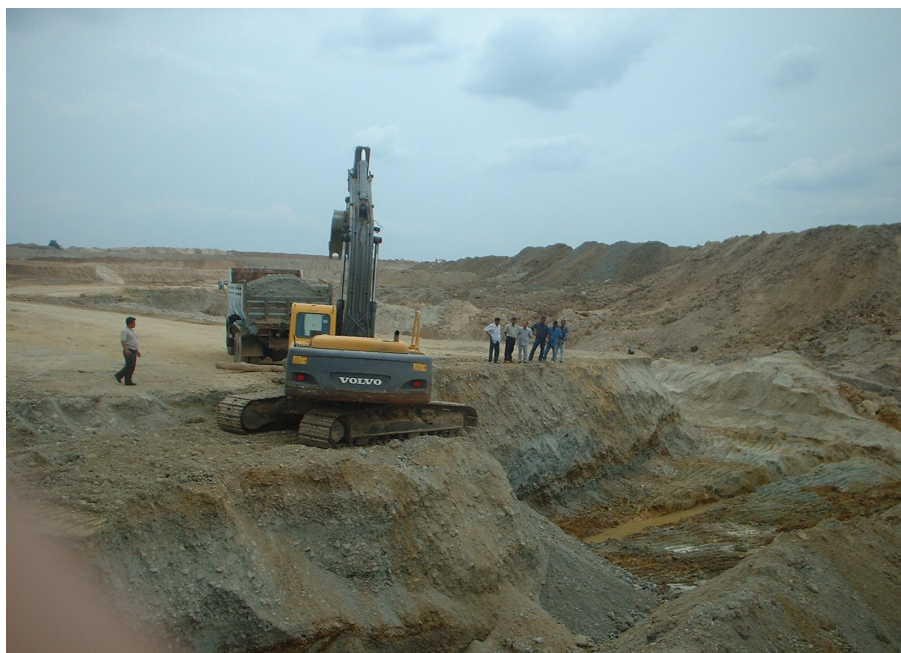
รูปที่ 4.28 ภาพถ่ายสภาพหน้าเหมืองพลอย เห็นชั้นดินปนกรวดทรายด้านบน และชั้นกะสะที่เป็นกรวดทรายที่มีแร่พลอย (ใต้พื้นที่รถแบคโฮยืนอยู่)
