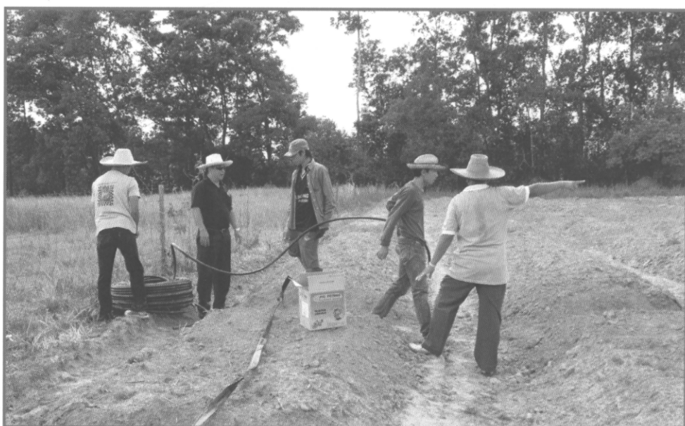
รูปที่ 15 การวางท่อและสายขางน้ำหยด
