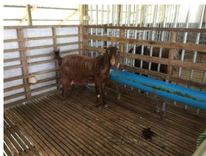
รูปที่ 1.1 ระแนงที่ใช้ปูพื้นโรงเรือนเลี้ยงแพะ
