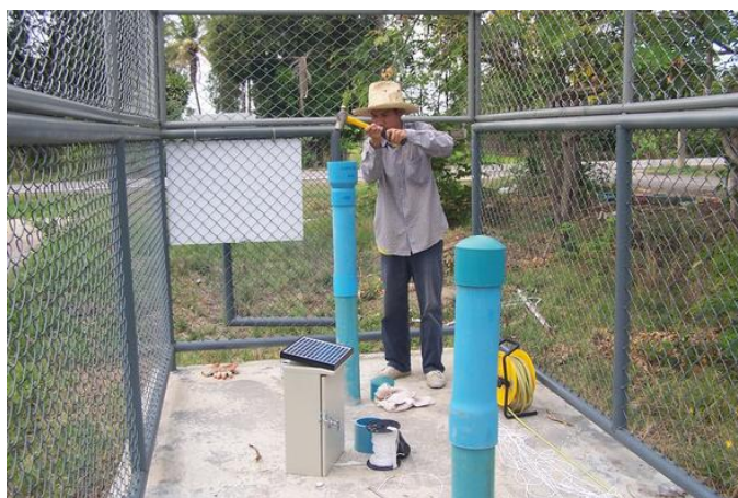
รูปที่ 2.5 ขั้นตอนการปฏิบัติงาน การเปิดปากบ่อสังเกตการณ์น้ำบาดาล
