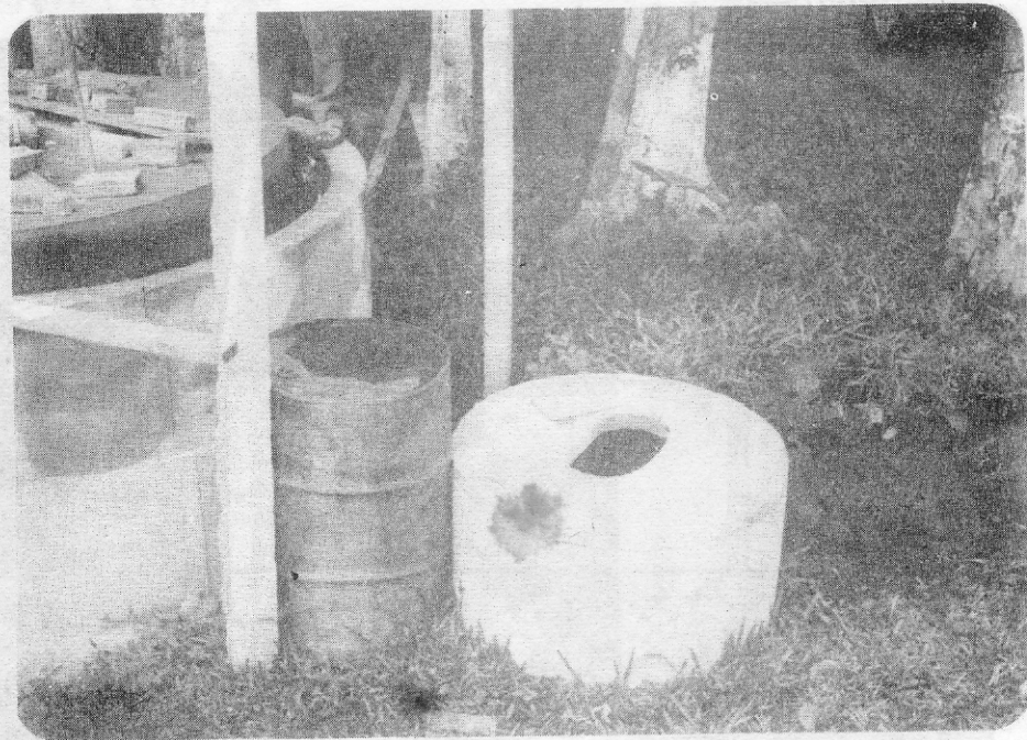
รูปที่ 6 บ่อหมักแก๊สที่หมู่ที่ 5 ต.บ้านพรุ อ.หาคีใหญ่ จ.สงขลา แสดงการระบายกากมูลสัตว์ที่ย่อยแล้ว
