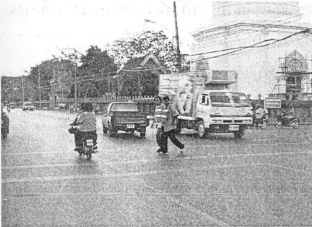
รูปที่ 3.2 : การตรวจสอบพื้นที่เป็นสิ่งที่จำเป็น และควร “เดินตรวจ” ในลักษณะเดียวกับผู้ใช้ถนนทั่วไป
