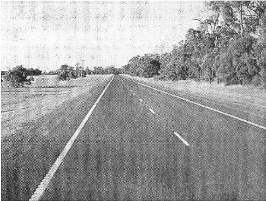
รูปที่ ก 2 : ถนนที่มีเขตปลอดภัย (Clear Zone) เพียงพอ
