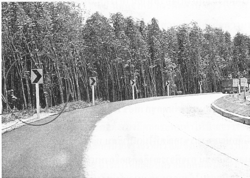
รูปที่ ๙ : ป้ายเตือนแนวทางที่วางอยู่บนเสาที่มีขนาดใหญ่เกินความจำเป็น
