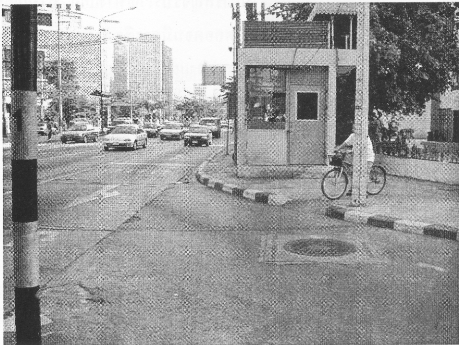
รูปที่ ก 5 : สิ่งปลูกสร้างบริเวณทางแยกที่อาจบดบังการมองเห็นของผู้ใช้ถนน
