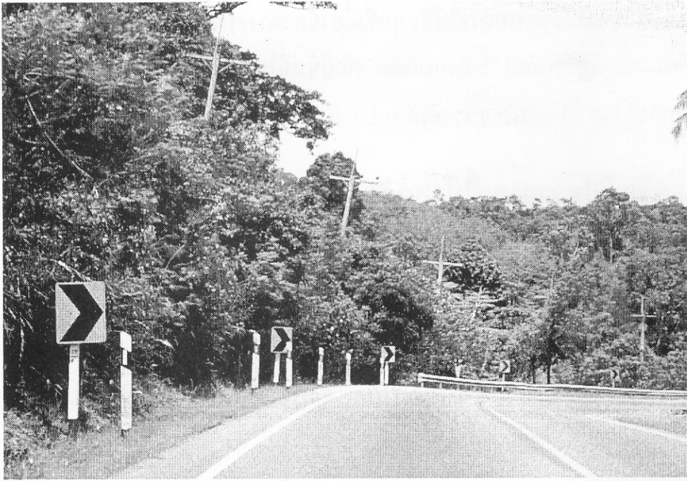
รูปที่ ก 1 : การติดตั้งป้ายเตือนแนวทางเพิ่มเติมบริเวณทางโค้งที่มีหลัคนำทาง ทำให้ทางโค้งอื่น ๆ ที่มีแค่หลัคนำทางอันตรายขึ้น
