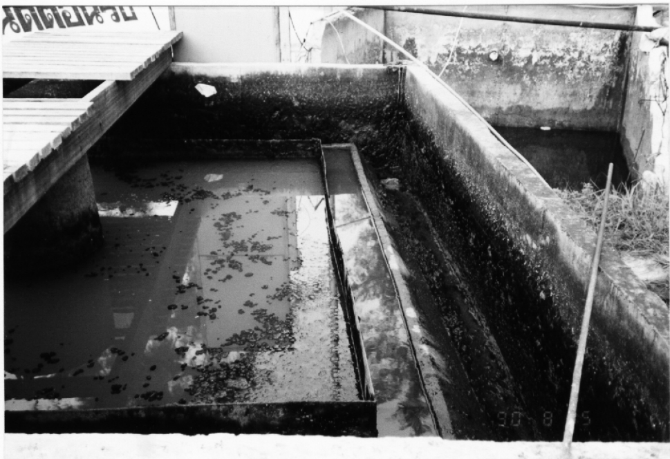
ภาคผนวก 8 สภาพถังตกตะกอนเมื่อระบบบำบัดไม่ทำงาน
