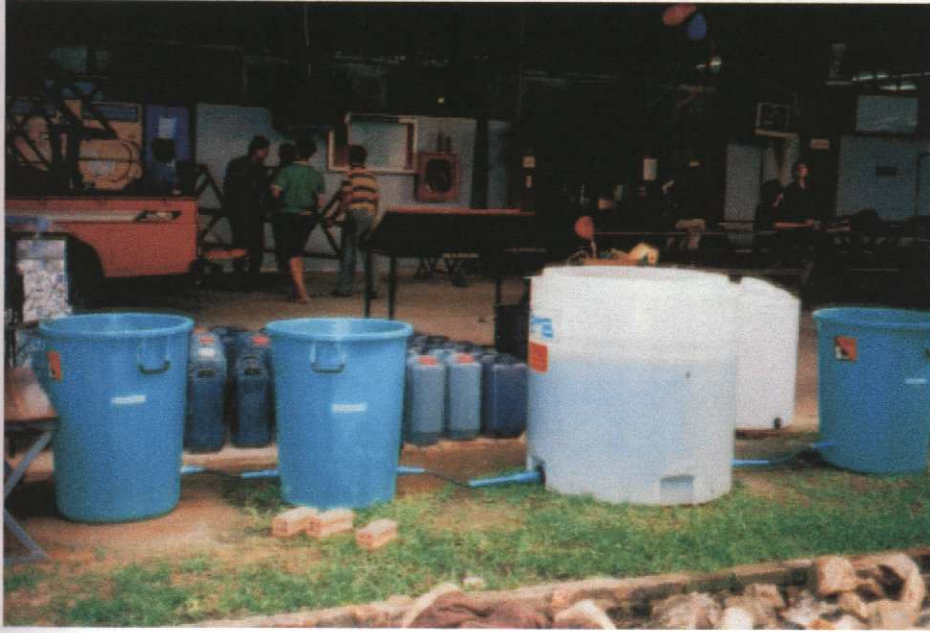
ภาพที่ 10 แสดงถึงเก็บกักน้ำและถึงจ่ายน้ำเข้าระบบ
