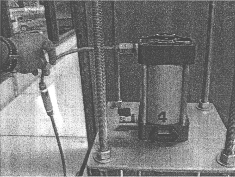
ภาพที่ 1.30 แสดงภาพการต่อสายสีฟ้าอุปกรณ์กันการไหลย้อนเข้าสู่ Air cylinder ที่วาล์ว ทางด้านบน (UP)
