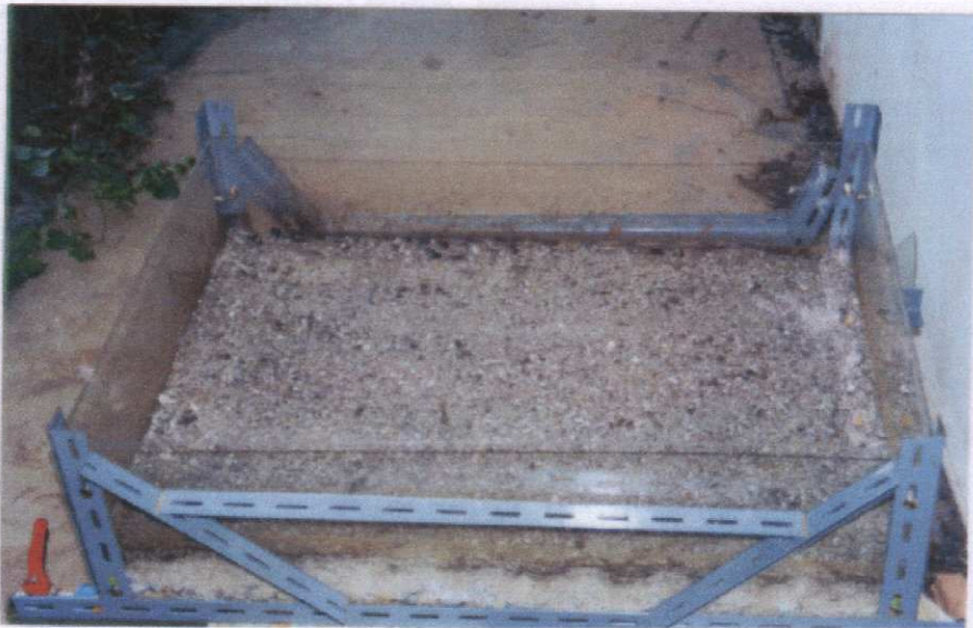
ภาพที่ 13 แสดงลานทรายตากตะกอน
