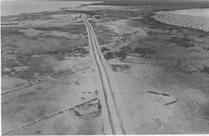
ภาพ ค6 ถนนสาย พท 3037 (ปี 2545-46) ที่ พาดผ่านพื้นที่ลุ่มระบายน้ำของทะเลน้อย (ในภาพทะเลหลวงอยู่ด้านซ้ายและทะเลน้อย อยู่ด้านขวา)
