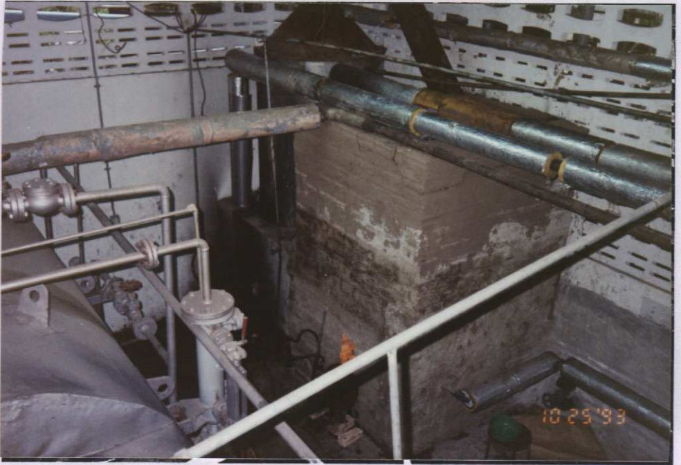
รูปที่ 3.7 เตาต้มน้ำมันเทอร์มัล และเตา SUPERHEAT
