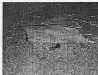
รูปที่ 7 ท่อให้ความร้อนของเตารุ่นปี 2537 ฝาครอบลอยขึ้นมาปากท่อ
