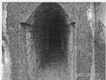
รูปที่ 14 ก่ออิฐทนไฟในเตาเผาเพิ่มเติมจากอิฐเดิมที่ชำรุด
