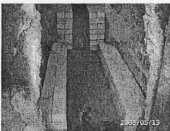
รูปที่ 14 ก่ออิฐทนไฟในเตาเผาเพิ่มเติมจากอิฐเดิมที่ชำรุด
