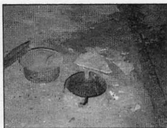
รูปที่ 7 ท่อให้ความร้อนของเตารุ่นปี 2537 ที่ใส่ฝาครอบลอบขึ้นมาจากท่อ
