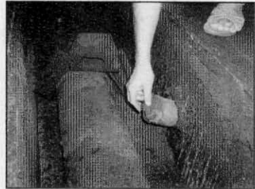
รูปที่ 9 ท่อให้ความร้อนของเตารุ่นปี 2538 การหาวัสดุมาปิดท่อให้ความร้อน
