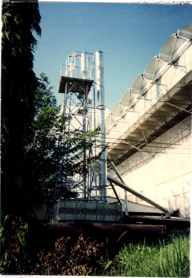
รูปที่ 3.12 ท่อส่งน้ำอากาศบารอเมตริก คอนเดนเซอร์ และ Booster
