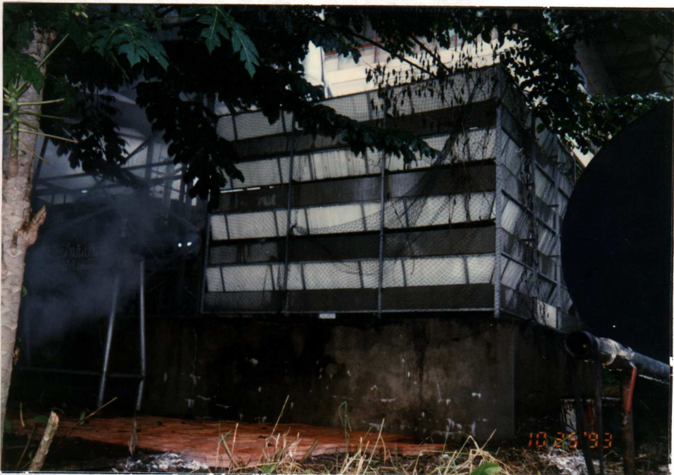
รูปที่ 3.13 ท่อฝังเข็มนและบ่อน้ำหมุนเวียน
