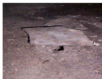
ภาพประกอบที่ 4-22 การทำฝาครอบลอยขึ้นมาบริเวณปากท่อเพื่อไม่ให้ความร้อนมากเกินไป
