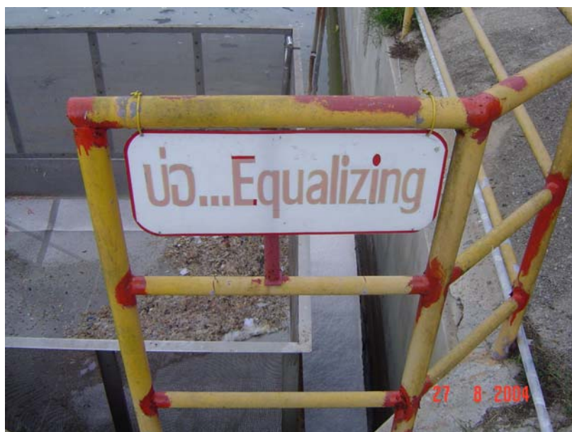
ภาพประกอบที่ 2.2 จุดเก็บตัวอย่างน้ำเสียรวมโรงงาน
