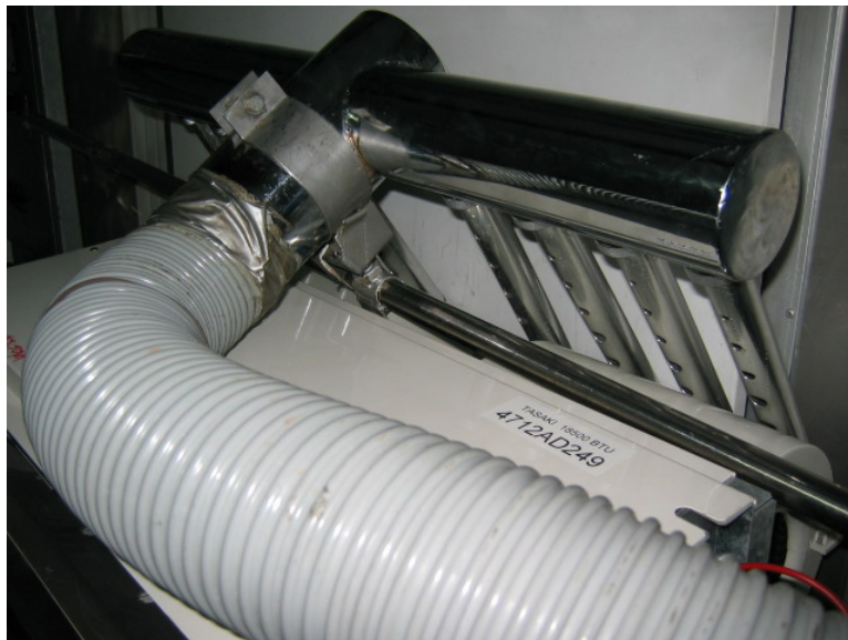
รูปที่ 3.4 แสดงลักษณะท่อเก็บตัวอย่างอากาศ
