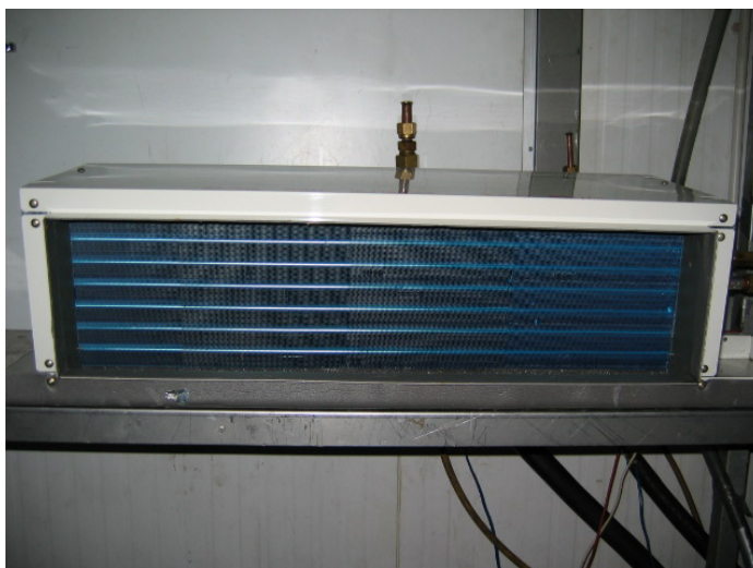
รูปที่ 3.6 ชุดคอยล์เย็น ( คอยล์เย็นติดตั้งอยู่กับชุดพัดลมเป่า )
