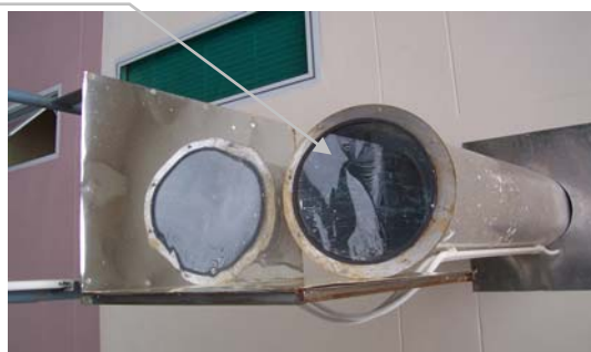
รูปที่ 4.11 ท่อนำแสงแบบแผ่นอลูมิเนียมผิวขัดมัน
