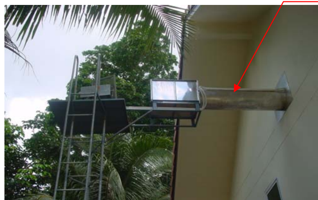
รูปที่ 4.13 การติดตั้งอุปกรณ์ท่อนำแสง
