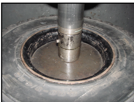
รูปที่ 4.17 อัดกระทะล้อเข้ากับล้อยางตัน
