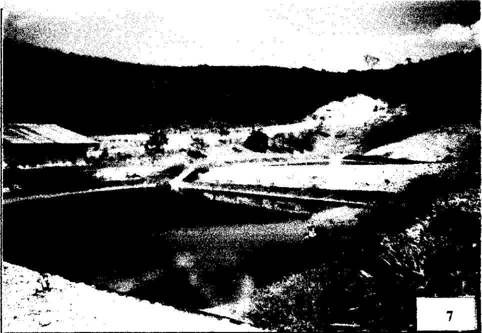
ภาพประกอบ 7 ระบบบำบัดน้ำเสีย สถานีที่ฝั่งกลามูลฝอยเทศบาลตำบลน้ำพุ และพื้นที่ต่อเนื่อง มีบ่อบำบัดน้ำเสีย จำนวน 3 บ่อ
