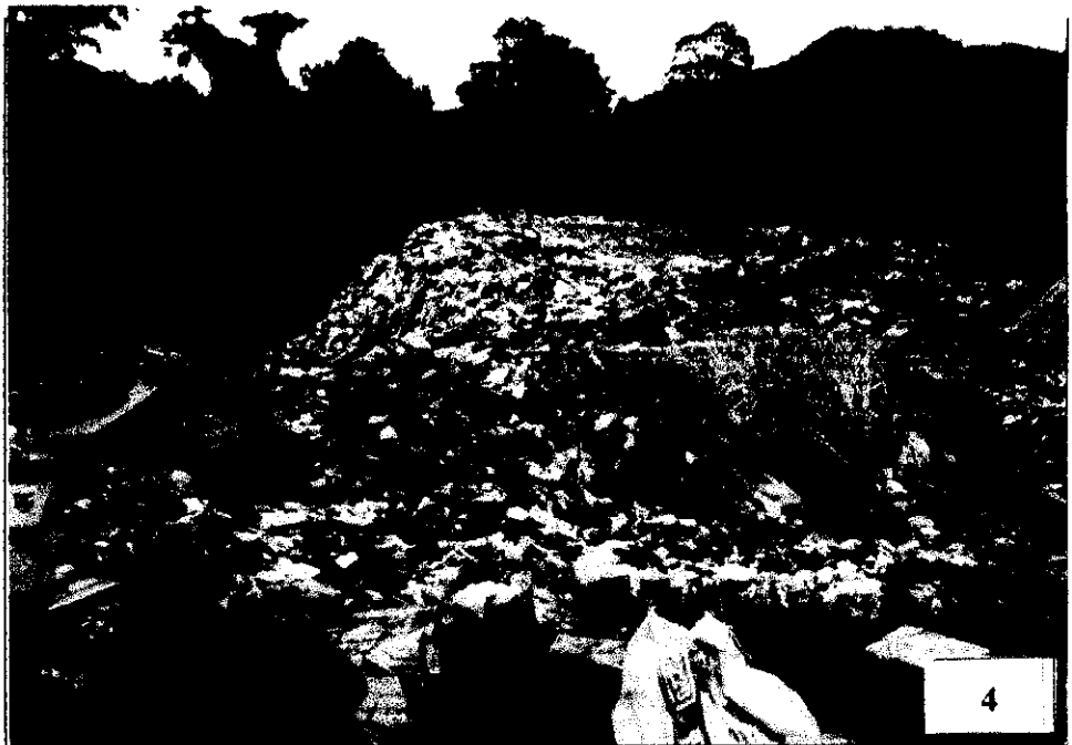
ภาพประกอบ 4 สถานที่กำจัดมูลฝอยไม่ถูกหลักสุขาภิบาล ใช้วิธีกองทิ้ง ไม่มีระบบป้องกันใดๆ ห่างจากแหล่งน้ำผิวดินประมาณ 150 เมตร
