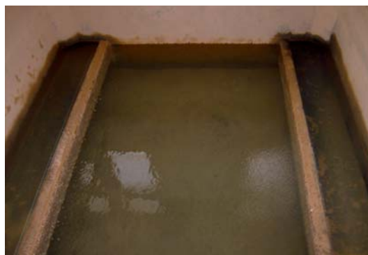
ถังทรายกรองระบบทรายกรองเร็ว (RSF)
