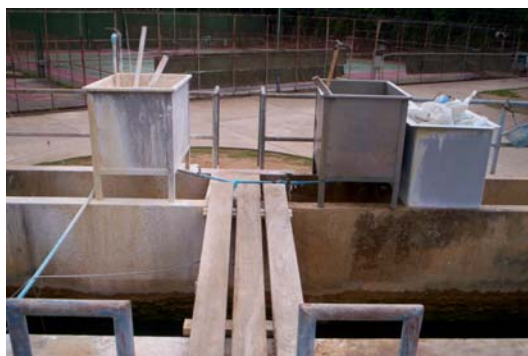
ถังเติมสารส้มและปูนขาวระบบทรายกรองเร็ว (LAT)
