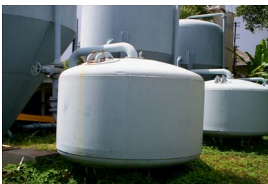
ถังทรายกรองระบบกรองแบบใช้แรงดัน (PSF)
