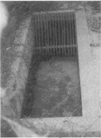
ข. สภาพตะแกรงที่รับน้ำเสียจากครัว
