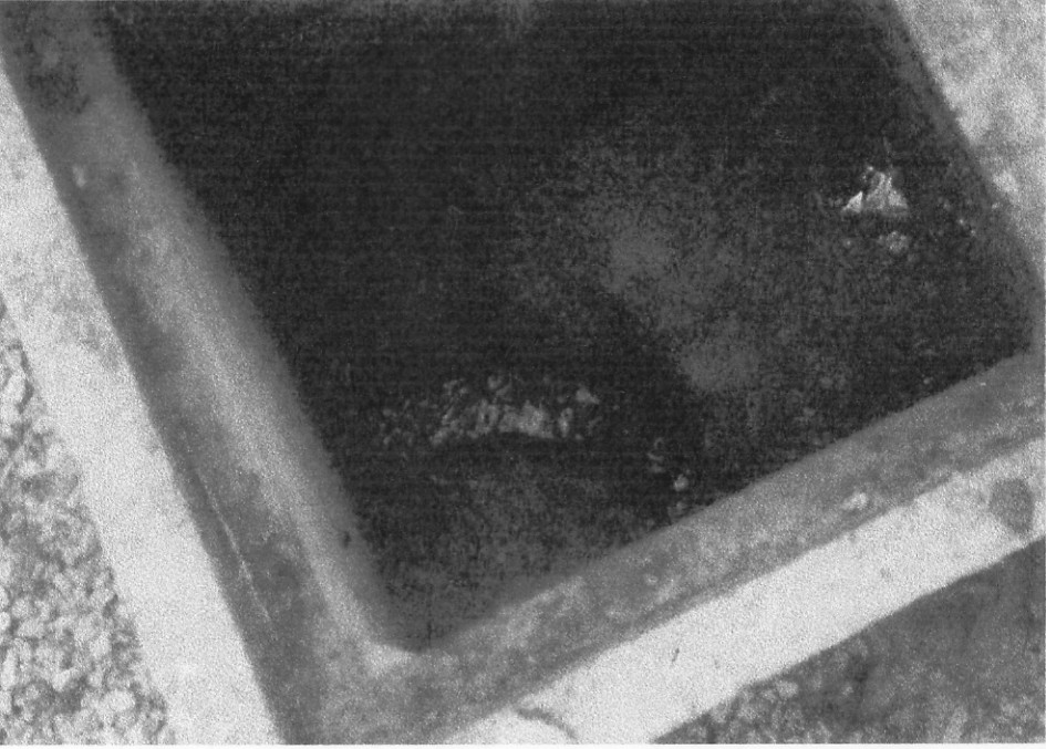
ก. สภาพภายในบ่อพักน้ำเสีย
