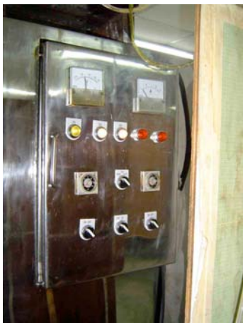
ภาพประกอบ 2-1 แสดงแผงควบคุมของเครื่องผลิตโอโซน
