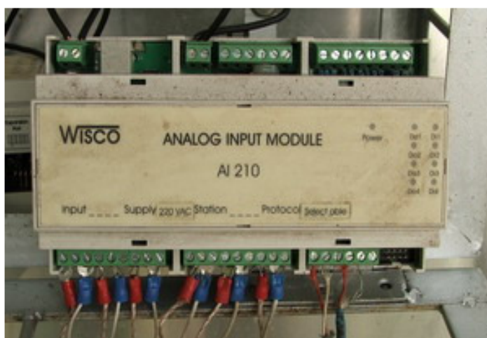
ภาพประกอบที่ ง-16 อุปกรณ์บันทึกและส่งข้อมูล (data logger) ยี่ห้อ Wisco รุ่น AI 210
