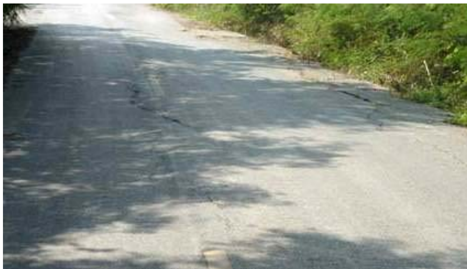
รูปที่ 1.4 การวิบัติของถนนแบบความเค้นดึง ถนนเกิดการแยกตัวแนวกึ่งกลางถนนเกิดจากความเค้นดึงที่เกิดจากการทรุดตัวของถนน เนื่องจากการก่อสร้างถนนบนชั้นดินอ่อน
