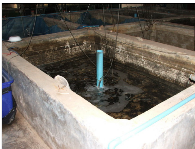
รูปที่ 20 บ่อพักน้ำเค็มที่ปรับค่าความเค็ม ก่อนนำไปใช้ในการเลี้ยงพ่อแม่พันธุ์ และใช้ในการทดลองภายในบ่อมีการให้อากาศตลอดเวลา
