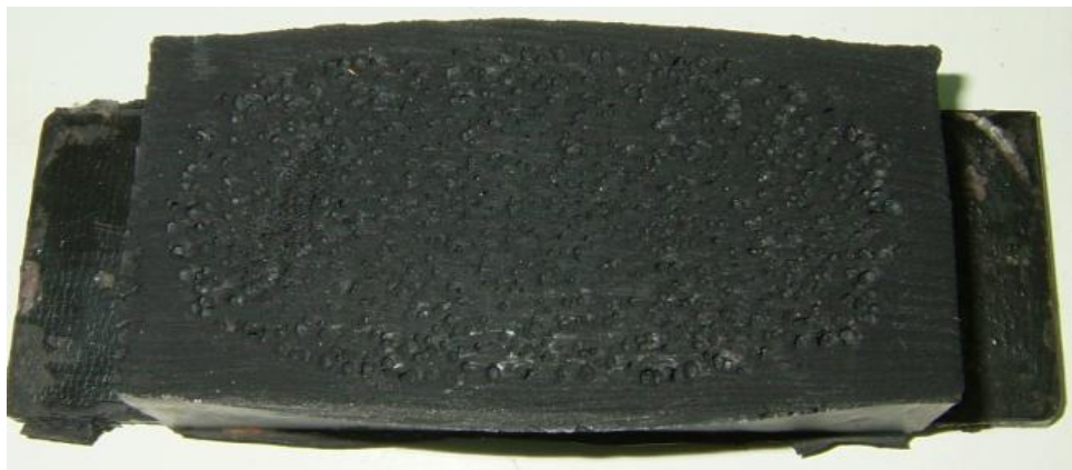
ภาพประกอบ 4.43 ลักษณะผิวภายในของยางรองคอสะพานที่ใช้เวลาในการอัด 20 นาที
