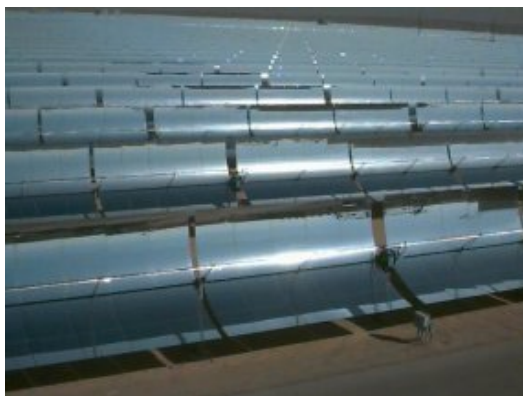
ภาพประกอบ 1.4 แสดงลักษณะของกระจกรับรังสีอาทิตย์แบบพาราโบลา
