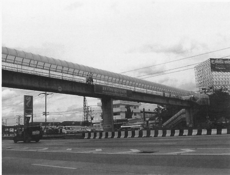
ภาพประกอบที่ 2.2 : สะพานคนเดินข้ามที่มีการติดตั้งหลังคาบังแดด บริเวณหน้ามหาวิทยาลัยกรุงเทพ
