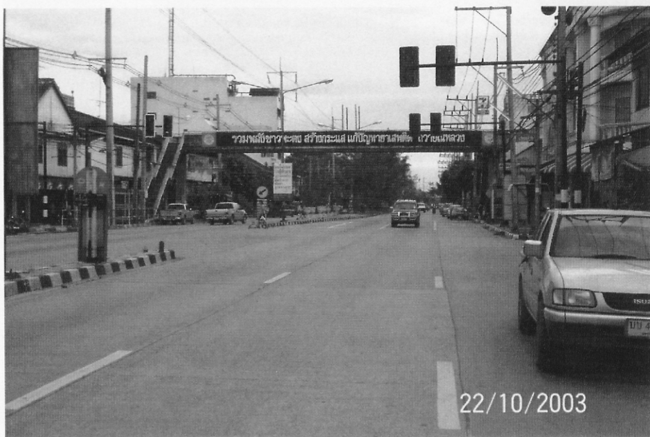
ภาพประกอบที่ ก7 : สะพานลอยบริเวณเขตชุมชนทุ่งสูง
