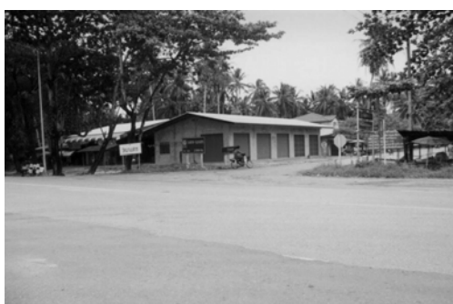
ฉ) ไฟฟ้าแสงสว่างไม่เพียงพอบริเวณทางแยก
