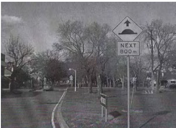
ภาพประกอบที่ 2.12 การติดตั้งป้ายเตือนล่วงหน้าก่อนถึงเนินชะลอความเร็ว
