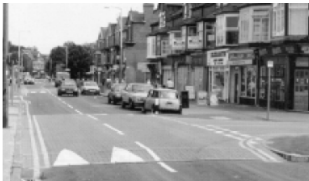
ภาพประกอบที่ 2.4 ทางแยกแบบขระดับผิวจราจรในเขตจำกัดความเร็ว 20 ไมล์ต่อชั่วโมง ที่มา: County Surveyors Society, Traffic Calming in Practice, 1994
