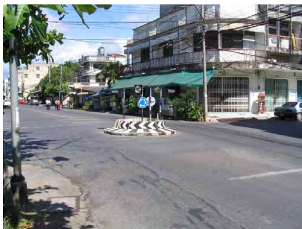
ภาพประกอบที่ 4.24 การทดลองติดตั้งวงเวียนเพื่อแก้ปัญหาอุบัติเหตุบริเวณ สี่แยกซอย 4 ถนน นิพัทธ์สงเคราะห์ 1 ตัดกับถนนนิพัทธ์สงเคราะห์ 4
