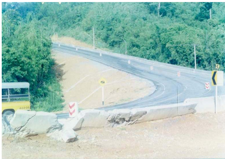
ภาพประกอบ 5.3 บริเวณถนน กม.65+000-67+000 ทางหลวงหมายเลข 323 ตอน ห้วยรันตี๋-ด่านเจดีย์ อ.สังขละบุรี จ.กาญจนบุรี หลังจากแก้ไขแล้ว
