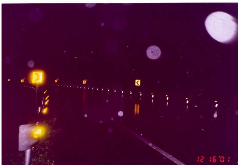
ภาพประกอบ 5.15 สภาพของถนนที่เกิดอุบัติเหตุ กม.14+200 ทางหลวงหมายเลข 41 ตอน อ.ทุ่งสง – จ.พัทลุง ขณะเกิดอุบัติเหตุมีฝนตก ถนนลื่น ไม่มีไฟฟ้าแสงสว่าง
