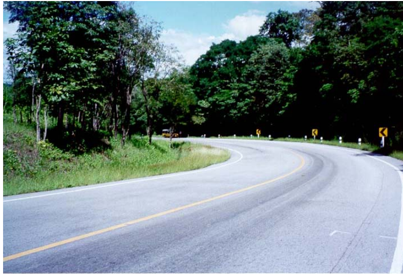
ภาพประกอบ 5.10 สภาพถนนก่อนเสนอมาตรการแก้ไขบริเวณที่เกิดอุบัติเหตุ กม. 27+650 ทางหลวงหมายเลข 203 ช่วงควบคุม 400 ตอน กม.30+000-สามแยกหน้าแขวงการทางเลยที่ 1
