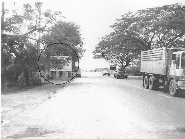
ภาพประกอบ 4.1 การติดตั้งป้ายบริเวณจุดต่อของเขตพื้นที่ก่อสร้างกับถนนเดิมที่มีอยู่ในปัจจุบัน มีต้นไม้บดบัง ตำแหน่งการติดตั้งอยู่ใกล้กับบริเวณที่มีการเปลี่ยนแปลงระดับพื้นผิวทาง หากขับรถมาด้วยความเร็วสูงอาจจะปรับตัวไม่ทัน โดยเฉพาะในเวลากลางคืน (กม. 0+000)
