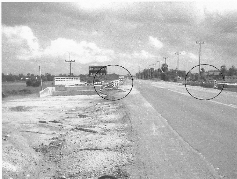
ภาพประกอบ 4.13 การก่อสร้างขยายสะพานบริเวณราวสะพานที่ยังไม่ได้รื้อย้ายออกไป อาจทำให้ผู้ ใช้ทางเข้าไปชนได้ (ทุกสะพาน)
