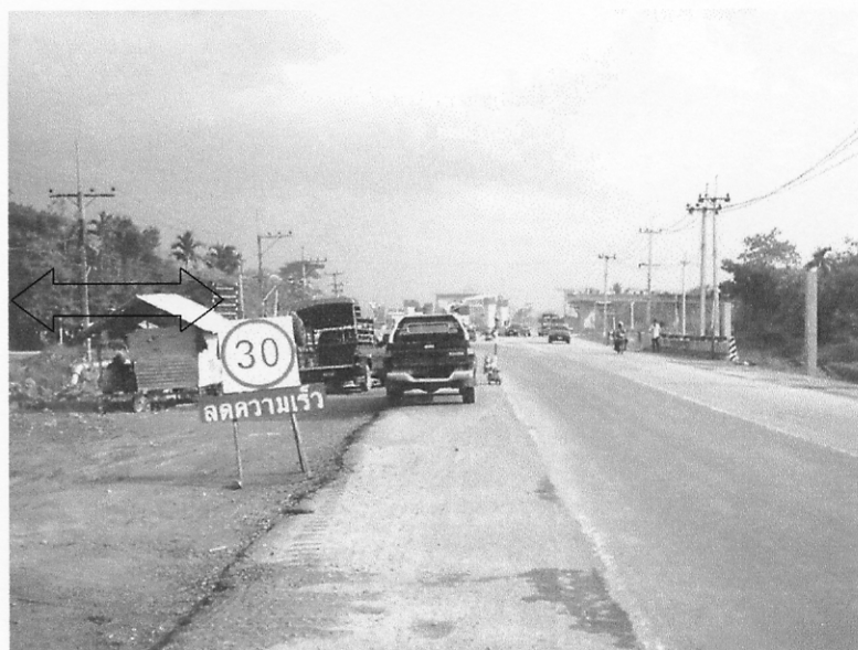
ภาพประกอบ 4.14 การจอดรถบริเวณไหล่ทาง และที่ปักชั่วคราวอยู่ในตำแหน่งบดบังการมองเห็น บริเวณทางเชื่อมเข้า-ออก (กม. 7+300)
