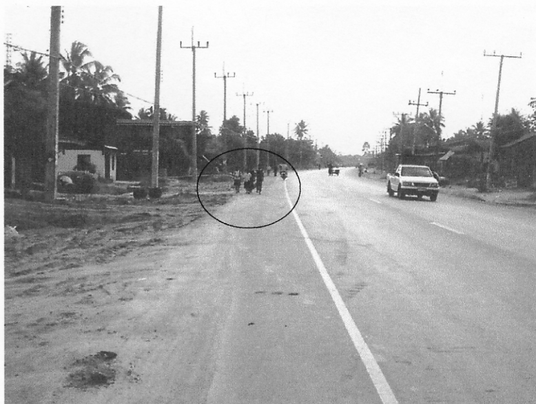
ภาพประกอบ 4.19 บริเวณทางสัญจรเดิมของคนเดินเท้าถูกรบกวนจากการก่อสร้างทำให้ต้องหลีกเลี่ยงมาใช้ไหล่ทางอาจได้รับอันตรายจากรถในช่องจราจรหลักได้
