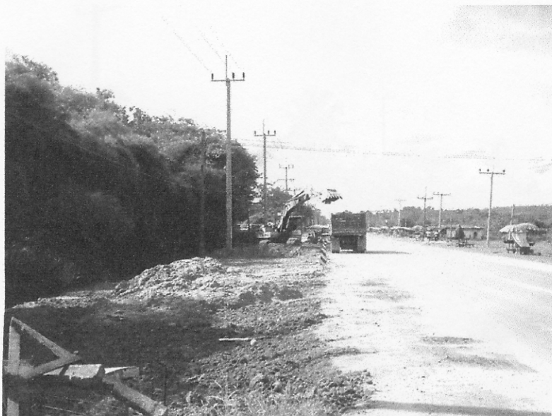
ภาพประกอบ 4.3 การปฏิบัติงานบริเวณข้างทางโดยไม่มีการวางกรวยจราจรนำทางในช่วงระยะผาย ความกว้าง หรืออุปกรณ์จราจรอื่นเตือน แสดงให้คนขับมองเห็นได้แต่ไกล
