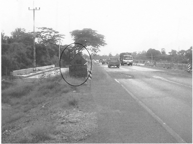
ภาพประกอบ 4.17 ป้ายจราจรซึ่งติดตั้งไว้ในบริเวณที่ไม่ได้มีการทำงานในบริเวณนั้น อาจสร้างความสับสน กังวลในการใช้เส้นทางได้
