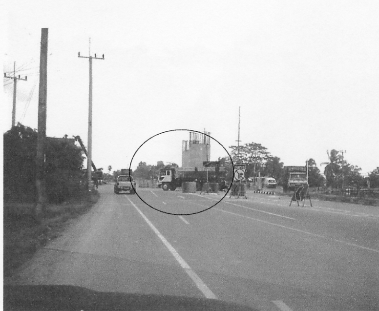
ภาพประกอบ 4.1 การติดตั้งป้ายบริเวณจุดต่อของเขตพื้นที่ก่อสร้างกับถนนเดิมที่มีอยู่ในปัจจุบัน มีต้นไม้บดบัง ตำแหน่งการติดตั้งอยู่ใกล้กับบริเวณที่มีการเปลี่ยนแปลงระดับพื้นผิวทาง หากขับรถมาด้วยความเร็วสูงอาจจะปรับตัวไม่ทัน โดยเฉพาะในเวลากลางคืน (กม. 0+000)
