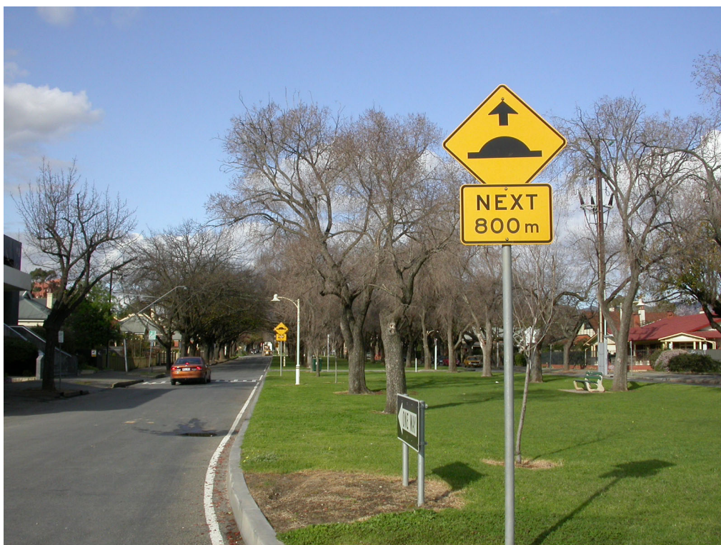
รูปที่ 2.15 การติดตั้งป้ายเตือนล่วงหน้าก่อนถึงเนินชะลอความเร็ว ที่มา : ด้วยความเอื้อเฟื้อจาก รศ.ดร.พิชัย ธานีรณานนท์
