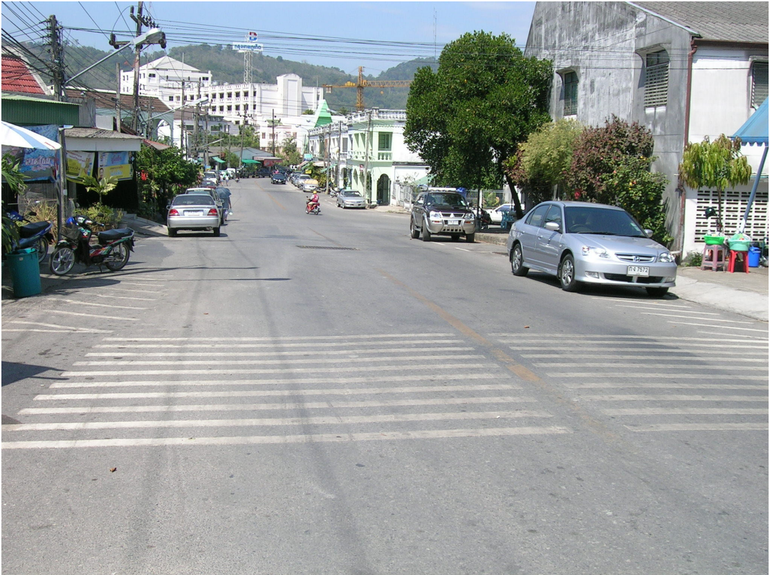
รูปที่ 4.23 ถนนหน้หยกอุทศ ภายในบริเวณชุมชนสามัคคีสามกอง
