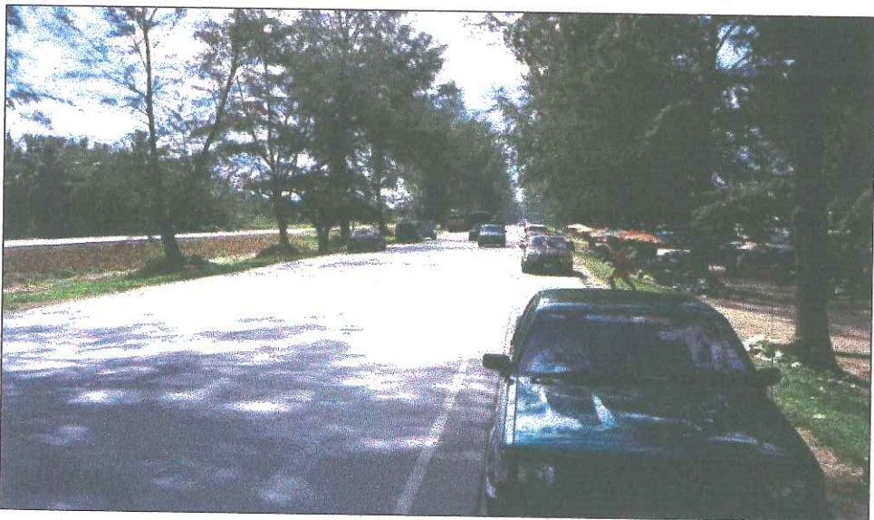
ภาพประกอบ 5.2 บริเวณ กม. 81+750-82+000 ทางหลวงหมายเลข 43 ซึ่งเป็นบริเวณที่มีศักยภาพในการก่อให้เกิดอุบัติเหตุ ประเภททางตรง เนื่องจากสิ่งแวดล้อมข้างทางที่ไม่เหมาะสม
