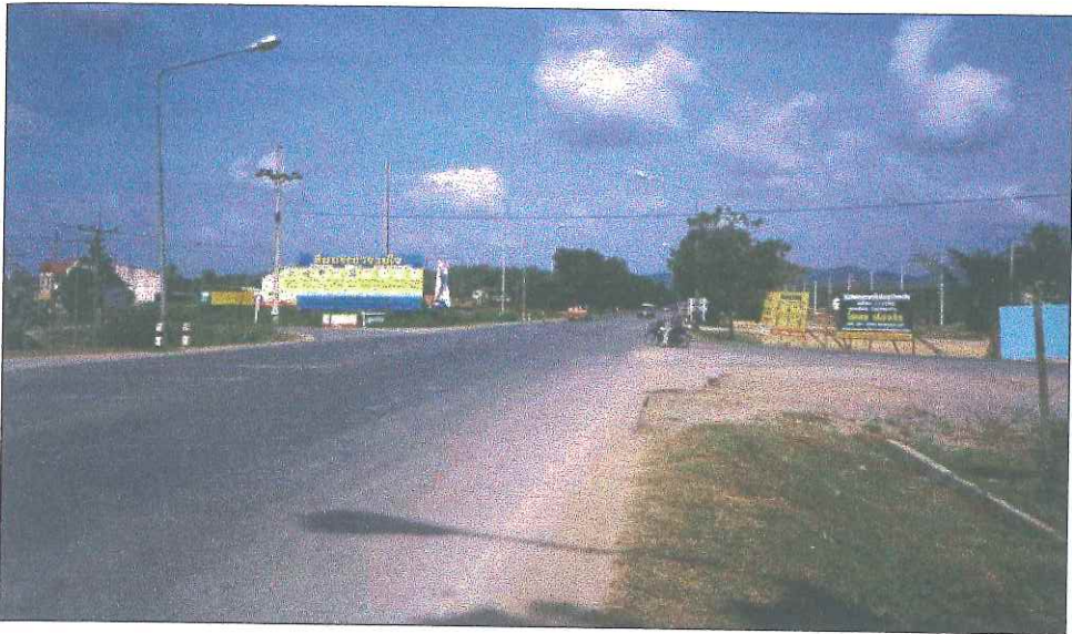
ภาพประกอบ 5.6 บริเวณ กม. 15+900 ทางหลวงหมายเลข 414 เป็นบริเวณทางแยกที่ไม่มีการควบคุมการจราจร ประกอบกับบริเวณสิ่งแวดล้อมข้างทางที่ไม่เหมาะสมอันอาจก่อให้เกิดอุบัติเหตุได้
