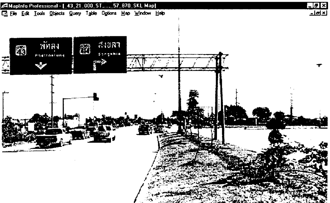
ภาพประกอบ ก22 ทางหลวงหมายเลข 43 คูหา-หาดใหญ่ บริเวณ กมที่ 21+575- 21+690 เป็นทางแยกอันตรายในลำดับต้น ๆ
